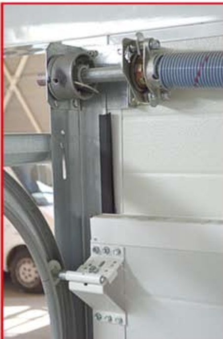
Detalle Sujeción Muelle Lateral.
